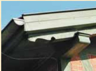
geschweiffter Sparrenkopf als „Pferdekopf“ und Pfettenkopf profiliert
