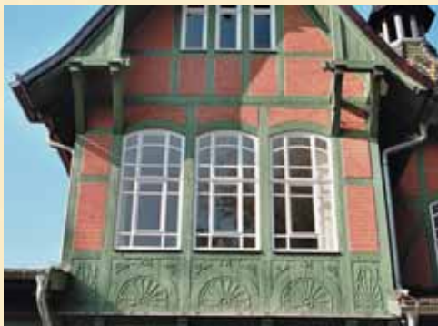
Hauptgiebel mit Sonnenscheiben und gewölbten Sturzriegeln
